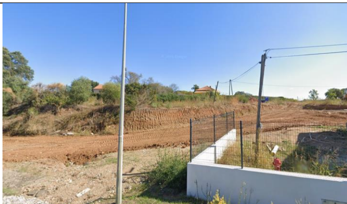
Vue directe depuis la T10 sur un lotissement en réalisation
